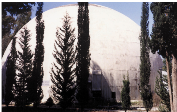
בתמונה: מבנה הסימולטור בבסיס הנ"מ, המשמש כיום כמבנה לימודים. שיפוצו מומן ע"י ברוך איבצ'ר.
